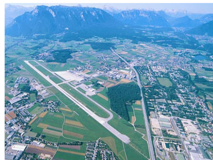
Luftaufnahme Flughafen Salzburg im Sommer 2002 Blick Richtung Süden
