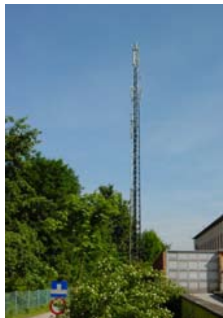
Wann wird bei der Errichtung von Handymasten endlich auf die Gesundheit der Anrainer Rücksicht genommen werden? Foto: mr
