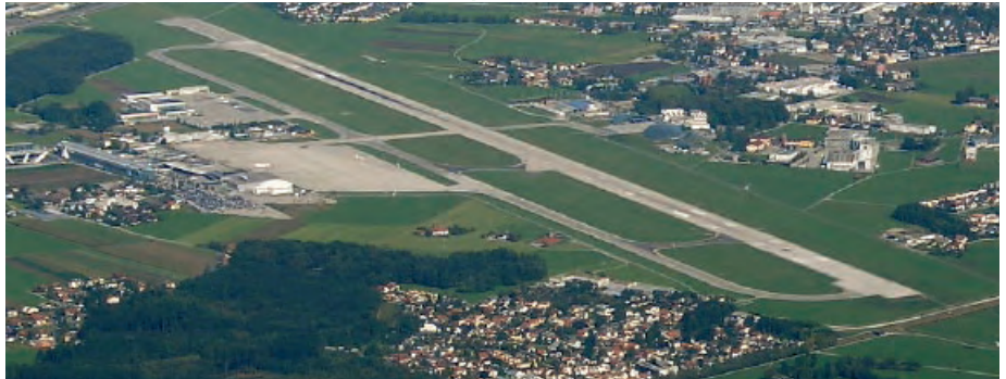
Flughafen im Stadtgebiet, umgeben von Siedlungen
