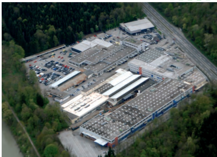
Betriebsgelände von MACO und Porsche im geschützten Auwald
