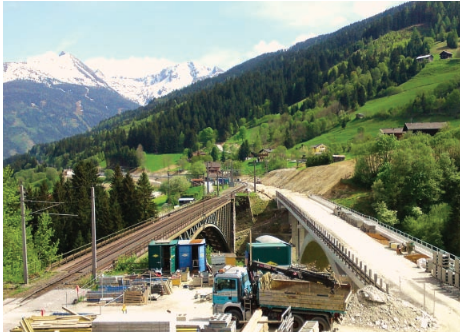
Alte und neue Angerschluhtbrücke
