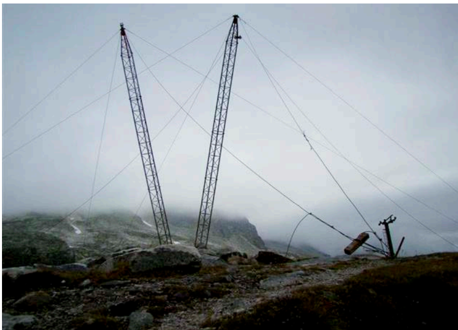
Die Bauarbeiten prägen den nationalparkträchtigen Raum
